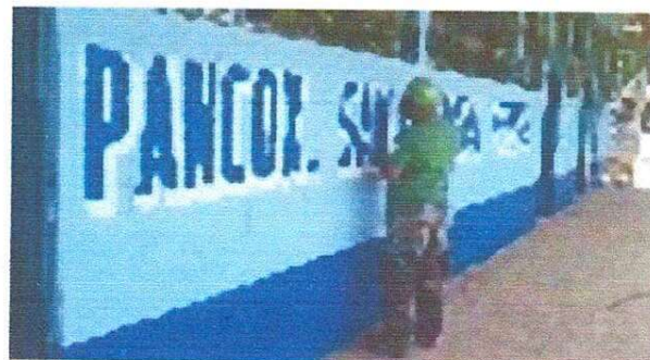
Foto 8: Durante el proceso de pintura y rotulación del establecimiento
