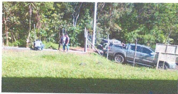
FOTO 7: Durante el proceso de trabajos del perímetro de colocación de malla
