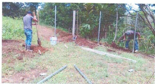
FOTO 7: Durante el proceso de trabajos del perímetro de colocación de malla
